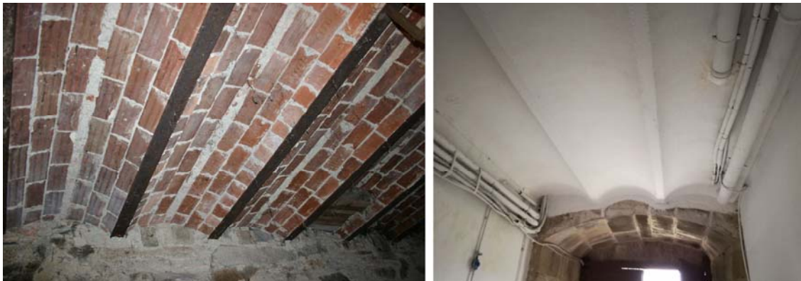
Figura 27. Forxados mixtos metálicos e de bovedillas de ladrillo en partes dos teitos dos sotos
