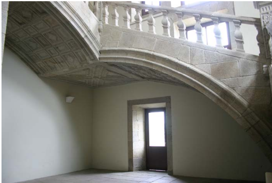
Figura 31. Escaleira monumental con dúas bóvedas acabalgadas sen apoios intermedios
