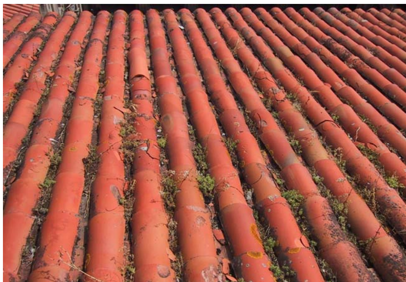
Figura 28. Roturas xeneralizadas das tellas da cuberta
