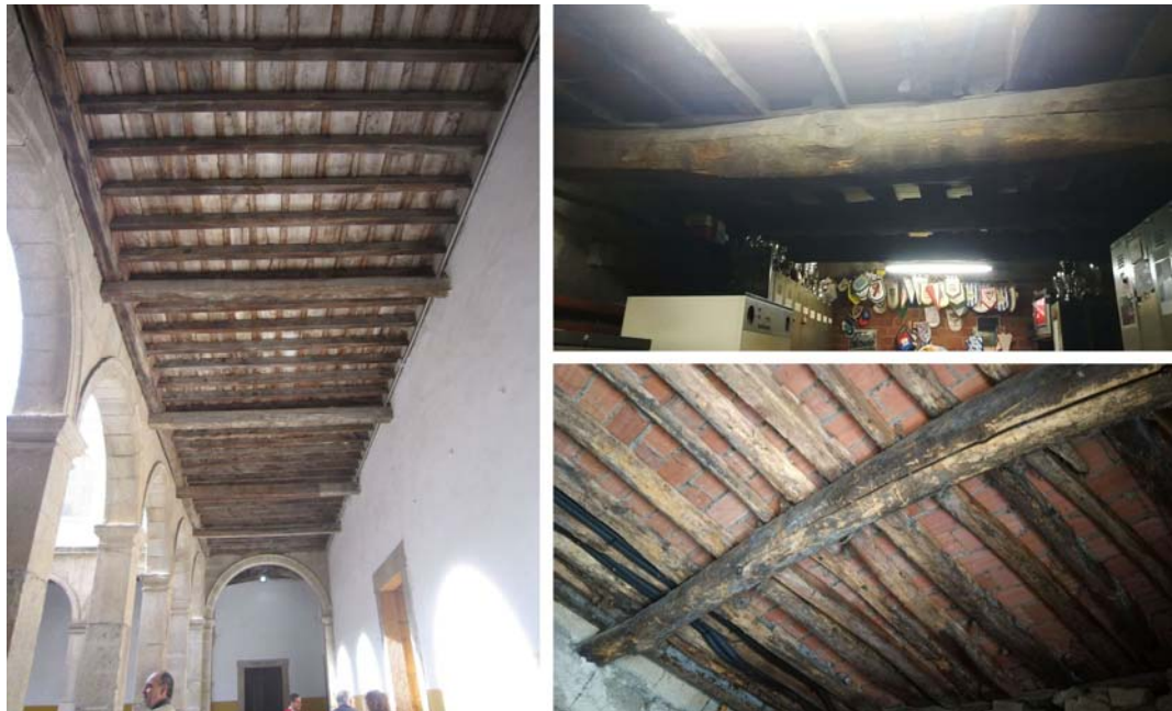
Figura 25. Forxados de madeira. Esquerda , claustro da esquerda; dereita arriba , zona utilizada polo Club Deportivo Calasancio nos sotos da ala esquerda; dereita abaixo , piso do pasadizo por detrás da igrexa.
