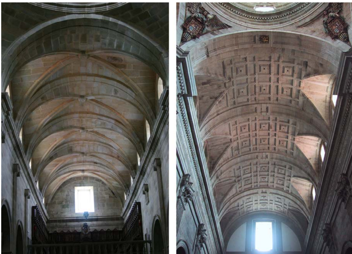
Figura 29. Esquerda , bóvedas de cruzaría na igrexa do mosteiro de Montederramo; dereita , bóvedas de canón con lunetos na nave da igrexa do Colexio
