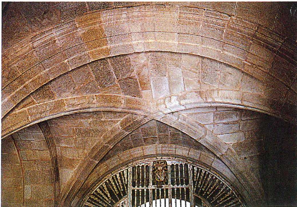
20. Abovedamiento del coro alto; iglesia de Montederramo.
