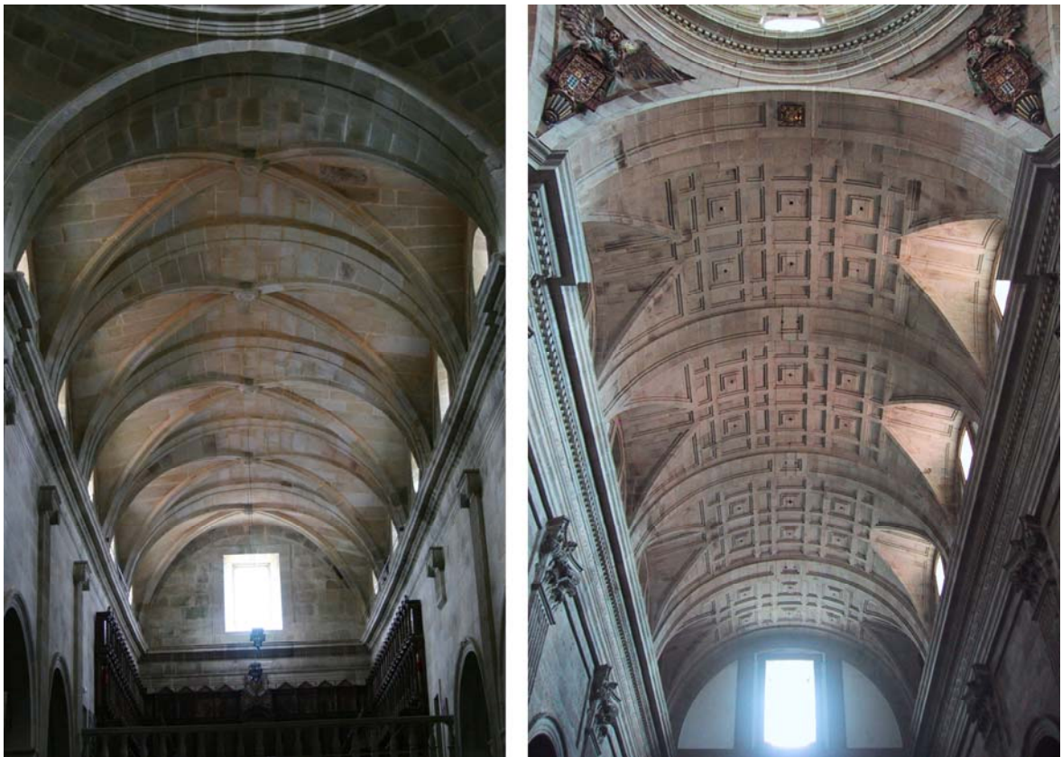
Figura 30. Esquerda , bóvedas de cruzaría na igrexa do mosteiro de Montederramo; dereita , bóvedas de canón con lunetos na nave da igrexa do Colexio
