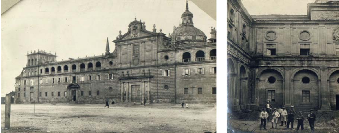
Figura 63. Balsa de la Vega, 1912. Esquerda : vista parcial da fachada principal onde se observa o extremo esquerdo da planta superior sen acabar; dereita : claustro principal coas arcadas pechadas nas dúas pandas construídas.
