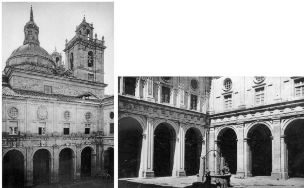
Figura 66. Arquivo Loty, ca. 1939. Esquerda : claustro principal, recanto oeste (compárese coa fotografía da mesma zona da Figura 76); dereita : recanto norte do mesmo claustro (obsérvese o cambio de cor da pedra: na panda representada á esquerda son novos piares e bóvedas; na da dereita só as bóvedas).
