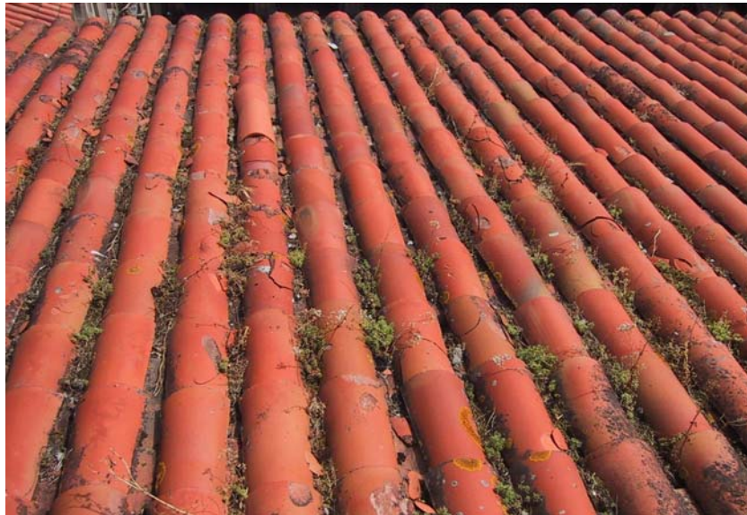
Figura 29. Roturas xeneralizadas das tellas da cuberta
