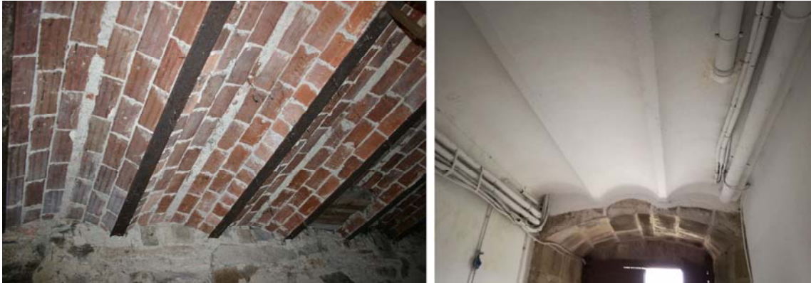
Figura 28. Forxados mixtos metálicos e de bovedillas de ladrillo en partes dos teitos dos sotos
