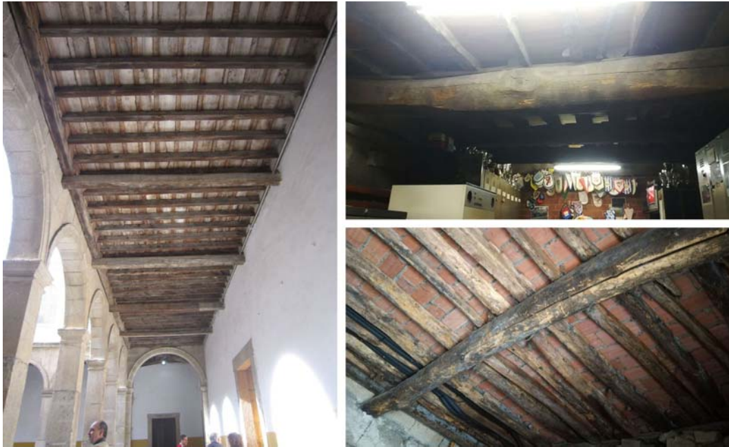
Figura 26. Forxados de madeira. Esquerda , claustro da esquerda; dereita arriba , zona utilizada polo Club Deportivo Calasancio nos sotos da ala esquerda; dereita abaixo , piso do pasadizo por detrás da igrexa.
