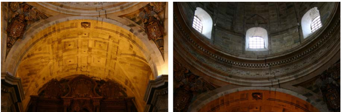
Figura 22. Esquerda , movementos na bóveda do presbiterio. Sobre o retablo unha doela descolgada. Dereita , gretas na cornixa da cúpula.
