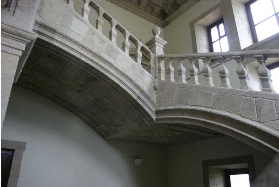
Figura 32. Escaleira monumental con dúas bóvedas acabalgadas sen apoios intermedios
