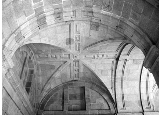
Figura 6 Fotografía de la bóveda del rincón que se desarrolla en la montea de la pared (foto de la autora 2011)
