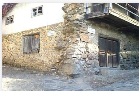
IMAGEN VI: Cruce de las calles de “Zapaterías” (izquierda) y del “Burato” (derecha) en la puerta de “Zapaterías”. Setiembre 2018
