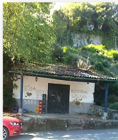
IMAGEN XVII: Bodega excavada en la roca al pie de un lienzo de la muralla en el “Campo de Ntra. Señora”. Setiembre 2018
