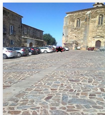
IMAGEN XVI: Vista parcial plaza en la que se levanta el Palacio (izquierda), lateral iglesia y acceso al monasterio (fondo). Setiembre 2018
