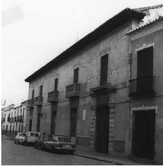
FIGURA 16 Fachada del Palacio de los Fúcares antes de la restauración. AGA
