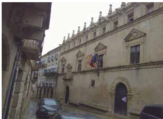
FIGURA 8 Ayuntamiento de Uncastillo, vista general de la fachada, estado actual
