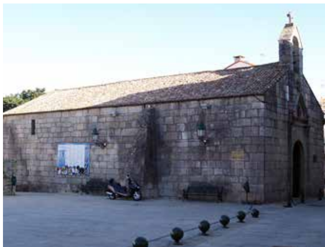
FIGURA 3 Capilla de la Misericordia. Baiona
