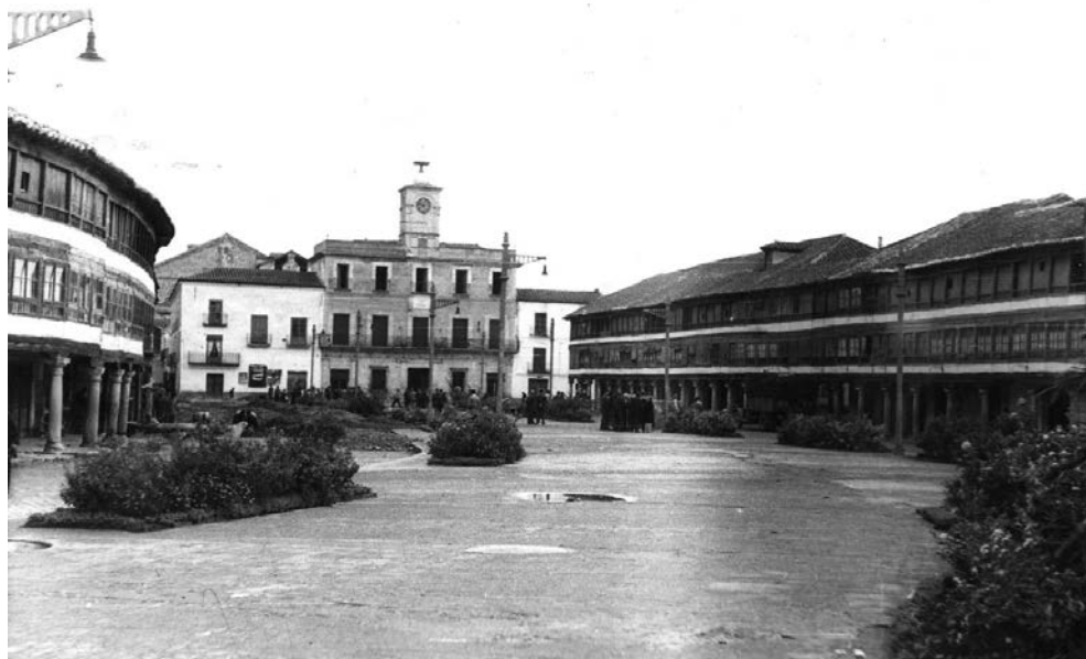
FIGURA 4 Plaza del ayuntamiento antes de la intervención. AGA
