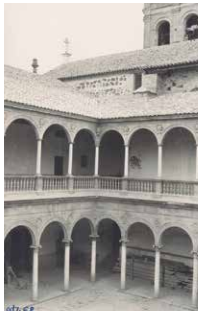
FIGURA 12B Claustro Dominicos restaurado. Octubre 1968. AGA
